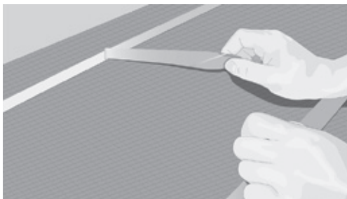
Bild 6. Lägga ut dubbelsidig tejp och ta bort baksidan
